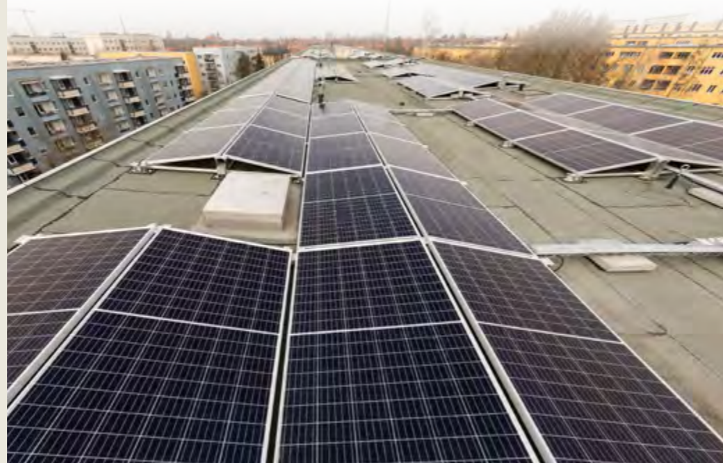
In Dölitz hat die LWB in mehreren Abschnitten ihre Plattenbauten saniert und PV-Anlagen installiert.
