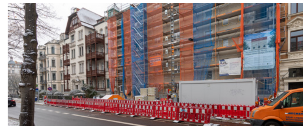
So unterschiedlich wie die Häuser, so vielfältig sind die baulichen Herausforderungen. PV-Anlagen werden installiert (Foto oben, Seipelweg), neue Balkone angebaut (kleines Foto links, Hardenbergstraße), die Loggien des Hochhauses erneuert (kleines Foto rechts, Bästleinstraße) und Fassadenarbeiten durchgeführt.
