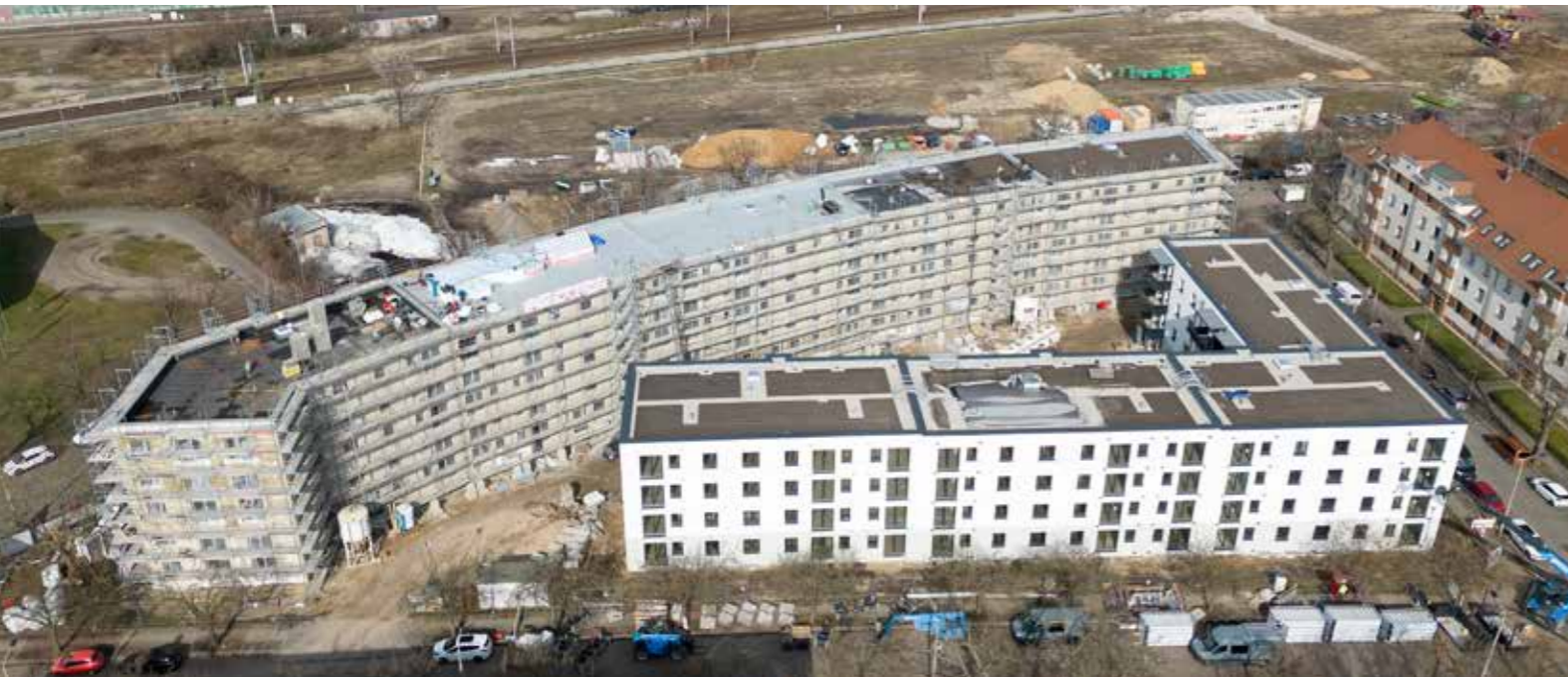
Die LWB baut an fünf Standorten derzeit: Gaußstraße.
